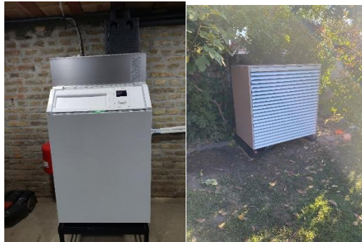
Slika 1 – Unutrašnja jedinica sa kompresorom i spoljašnja jedinica
