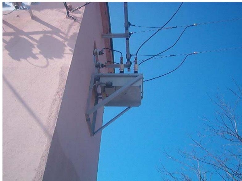
Za povezivanje sa daljinskim upravljačkim sistemom obezbedjen je priključak RS485 RTU koji nudi 300 - 19,2k bauda, u punom i polu-dupleks režimu. Od ponudjenih standardnih protokola izabran je Modbus komunikacioni protokol koji se uklapao u postojeći sistem daljinskog upravljanja. Kao prenosni put može se koristiti radio-veza, PTT linija ili GSM mreža. U konkretnom slučaju korišćena je radio veza na 0,7 m postojećeg sistema daljinskog upravljanja u Elektro distribuciji Kraljevo.
